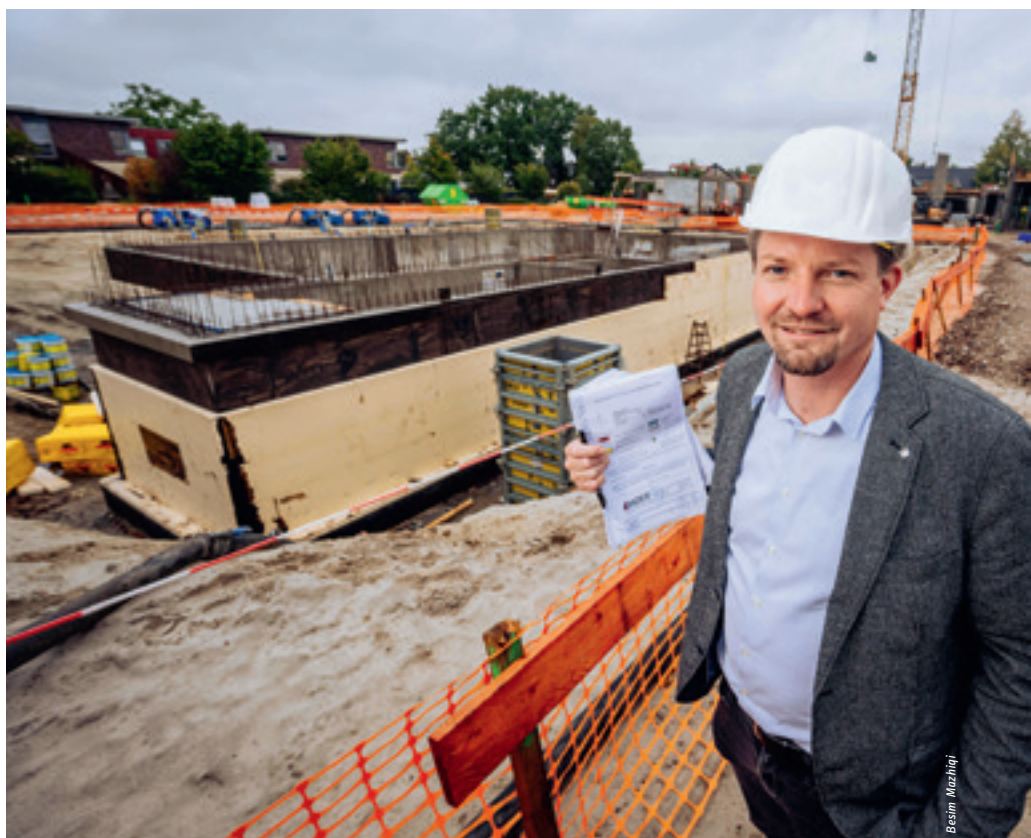
Immer einen Blick auf die Baustelle hat Schulleiter Jörg Hunschede. 2900 Kubikmeter Beton werden in der neuen Johannesschule verbaut.
